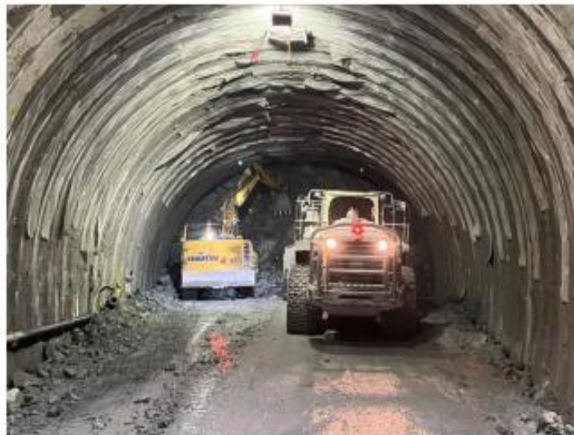
渡島トンネル(台場山) トンネル掘削工施工状況
